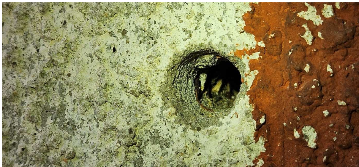
Rys. 5. Odkrywka ukazująca supremę, wskazanie wigotności materiału nie przekraczało 17%
