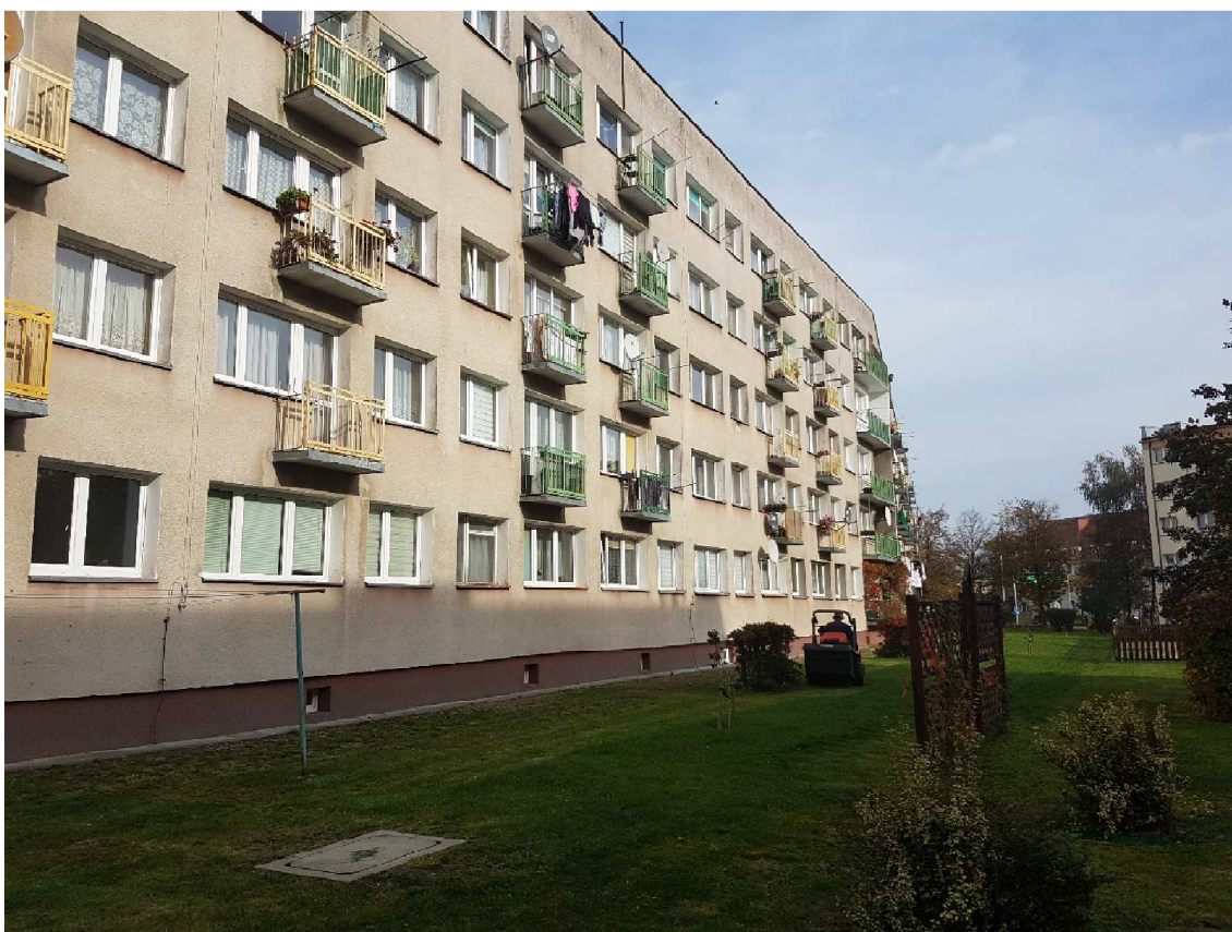
Fot. 3. Widok tylnej elewacji budynku zlokalizowanego przy ul. Stefana Żeromskiego 46-60
