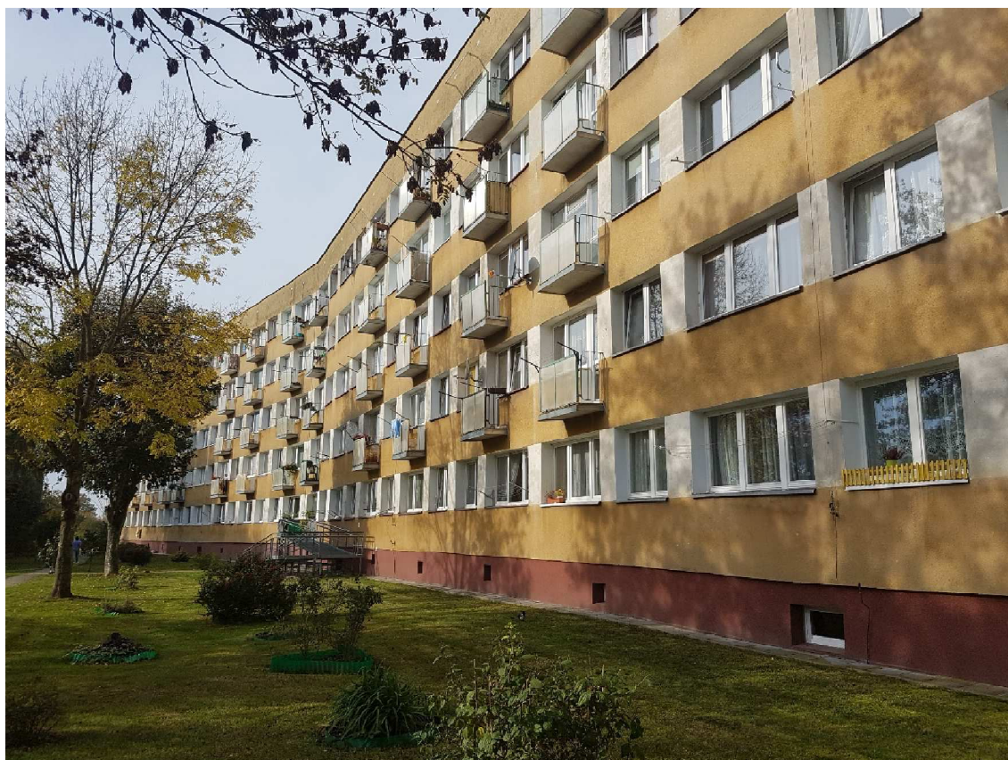
Fot. 1. Widok tylnej elewacji budynku zlokalizowanego przy ul. Stefana Żeromskiego 22-36
