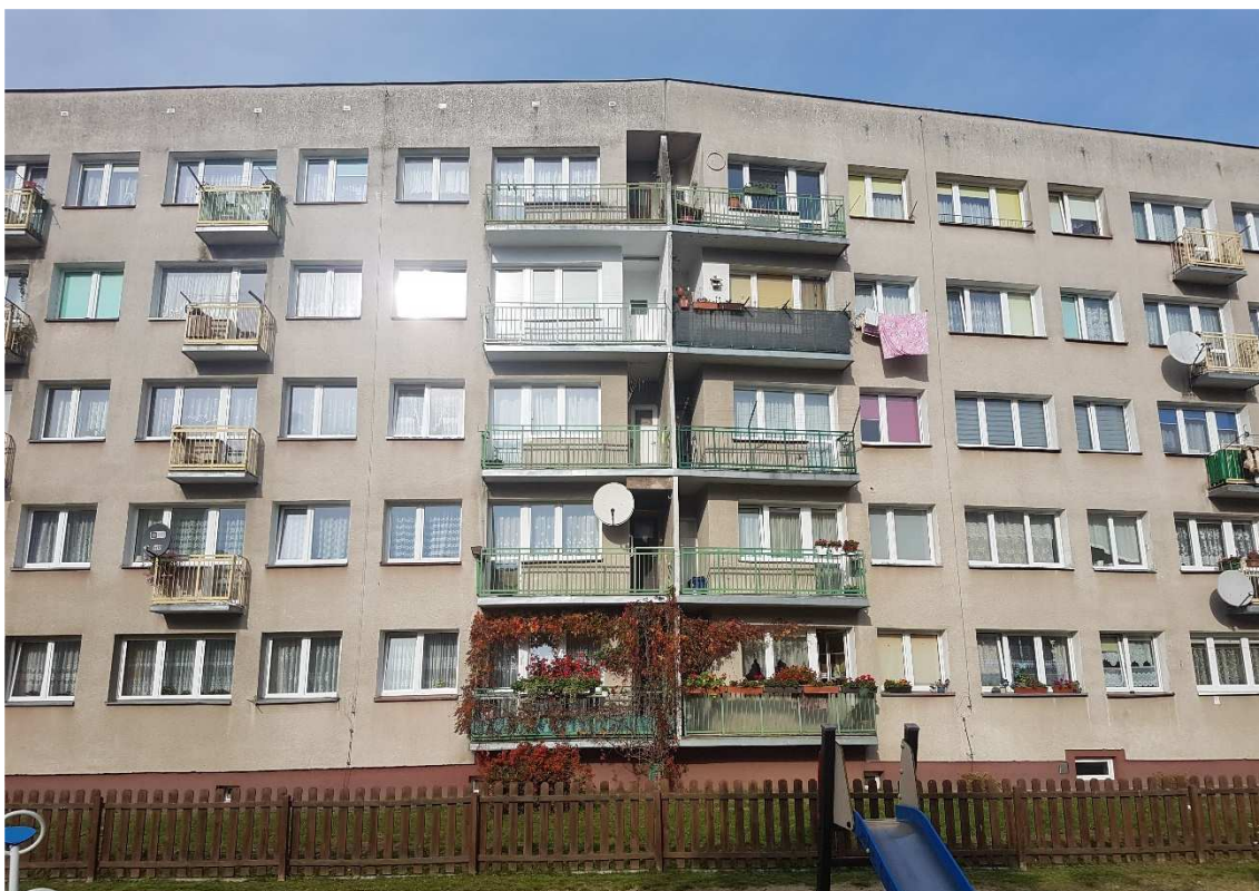
Fot. 7. Balkon wspornikowy typu B
