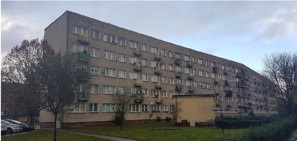
Fot. 4. Widok tylnej elewacji budynku zlokalizowanego przy ul. Władysława Reymonta 32-34c
