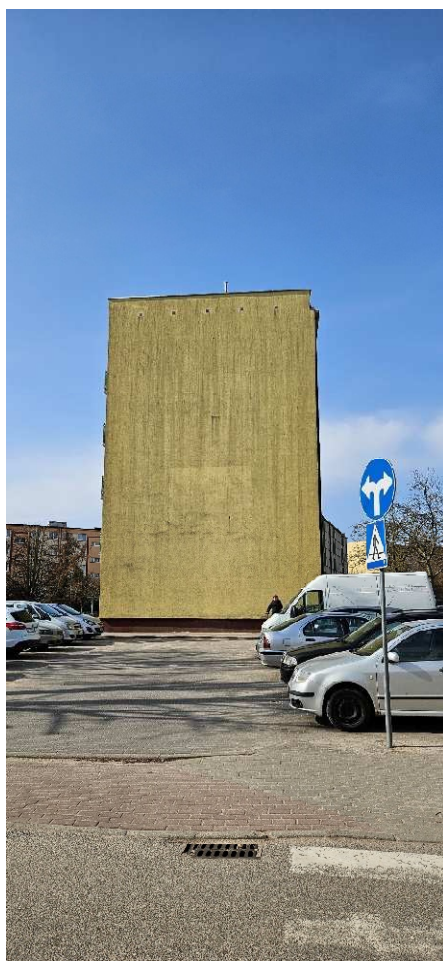
Rys. 3. Widok ściany szczytowej jednego z opisywanych budynków.
