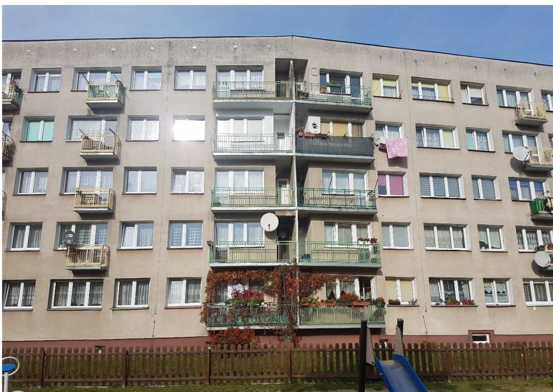
Fot. 7. Balkon wspornikowy typu B
