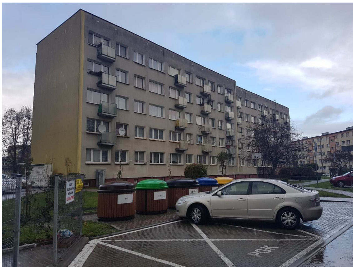
Fot. 2. Widok tylnej elewacji budynku zlokalizowanego przy ul. Stefana Żeromskiego 38-44
