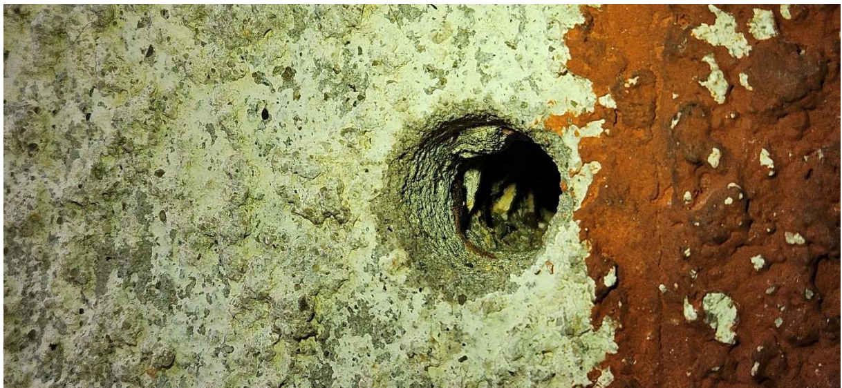
Rys. 5. Odkrywka ukazująca supremę, wskazanie wiotkości materiału nie przekraczało 17%
