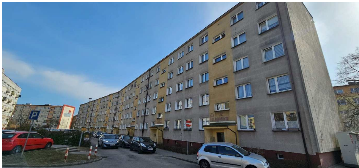
Rys. 2. Widok ściany podłużnej jednego z opisywanych budynków.
