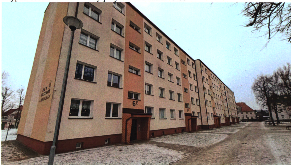
Zdjęcie 10. Blok mieszkalny przy ul. Moniuszki 6-6e
