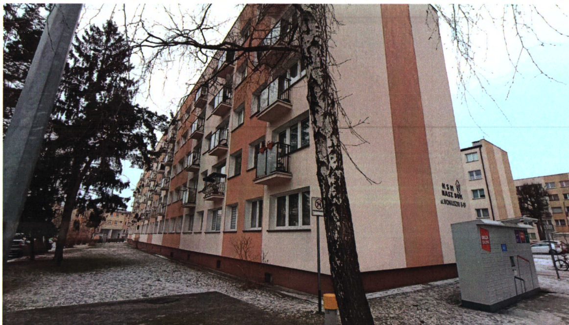
Zdjęcie 13. Blok mieszkalny przy ul. Moniuszki 8-8e
