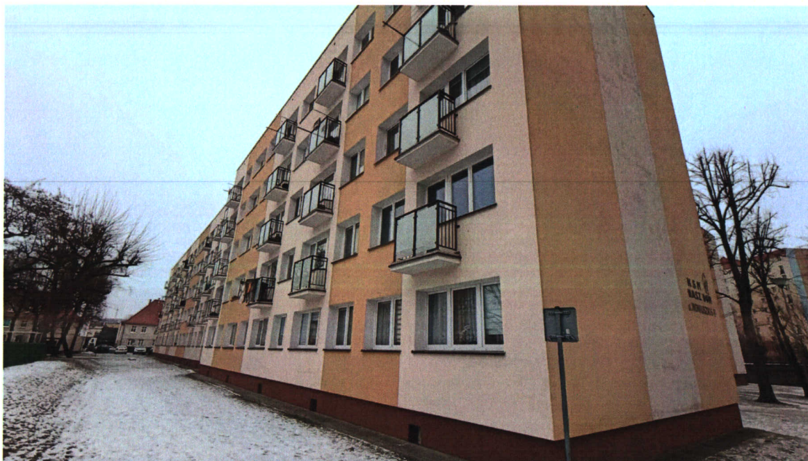
Zdjęcie 11. Blok mieszkalny przy ul. Moniuszki 6-6e
