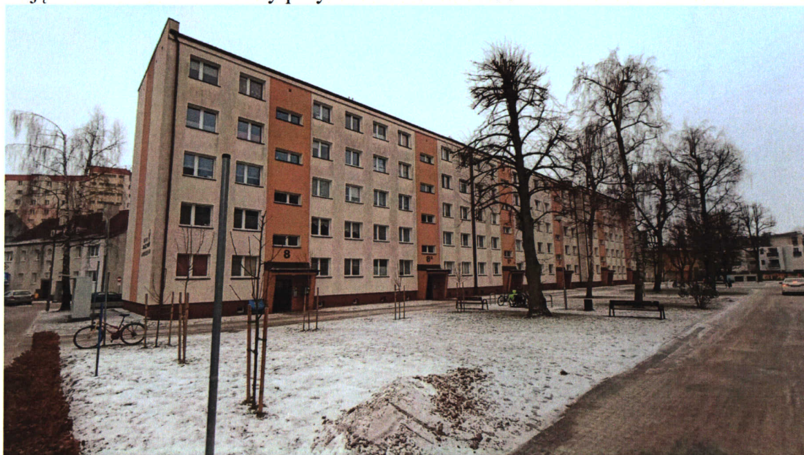
Zdjęcie 12. Blok mieszkalny przy ul. Moniuszki 8-8e
